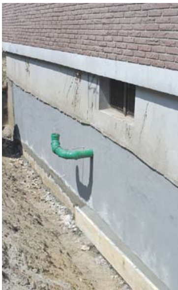
Foto: MC-Bauchemie, Bottrop
