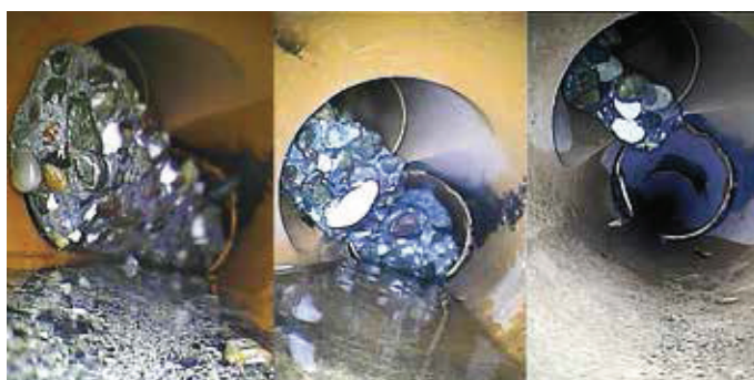
Schrittweise wird ein Betonpfropfen in der Leitung mit FST entfernt. Im Bild rechts erkennt man im Rohrscheitel einen Bruch, der für die Flutung des Rohrs mit Beton mit ursächlich war.
