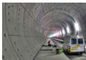
Tunnel-Retter im Einsatz.
